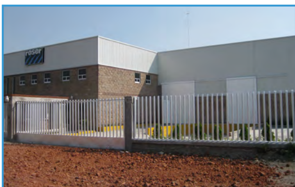
Nuevas instalaciones de ROSER en Toluca México
